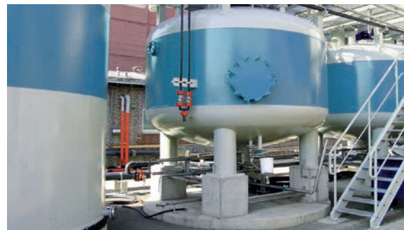
Professionelle stationäre Anlagen für die Schlammentwässerung und Ölschlammabtrennung werden von uns nicht nur geplant, gebaut und betrieben, sondern auch in vollem Umfang finanziert
